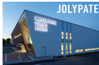
ジョリパット透湿外断熱システム パッシブウォール 物件名：札幌市カーリング場 設計：株式会社山下設計北海道支社 施工：西松・国策特定共同企業体
